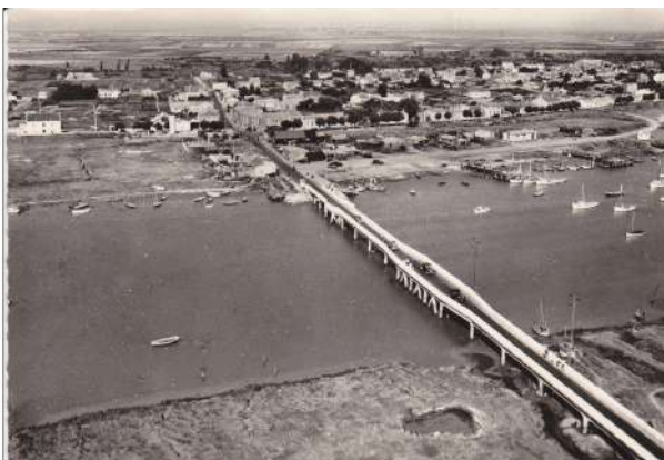
Le pont sur le Lay entre L'Aiguillon au nord et La Faute-sur-mer au sud
